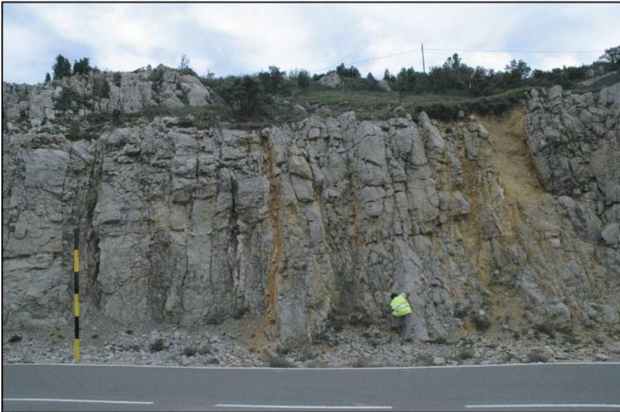
Figura 7.22: Toma medidas en el talud de la estación 10.
