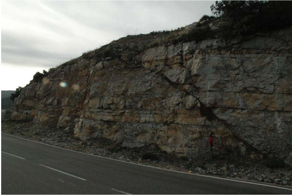
Figura 7.12. Talud de la estación 5 atravesado por una falla.
